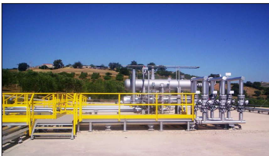
Vista del piazzale pozzo AC2 - C.le di Garaguso
